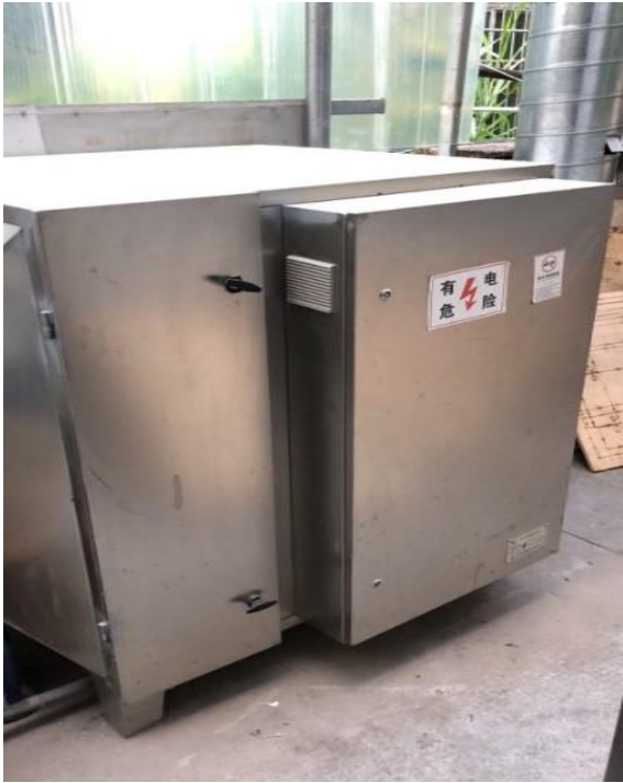
印刷废气处理设施照片
