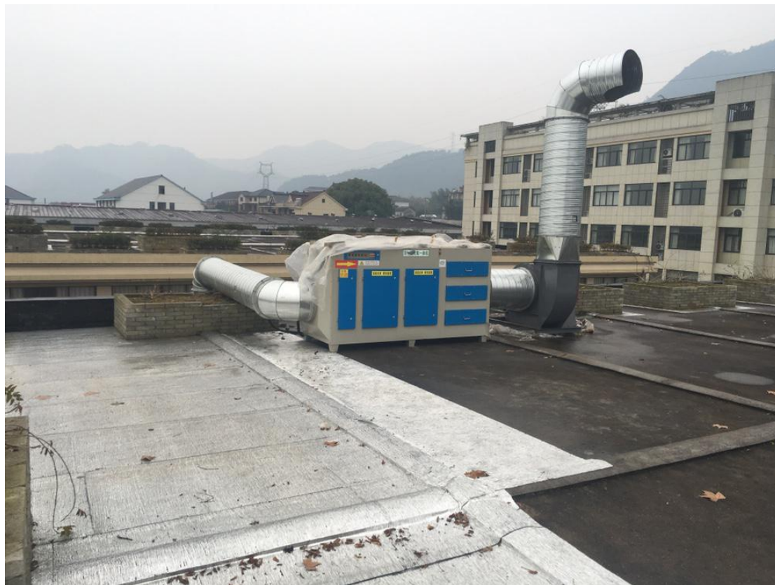
出型废气处理设施（光催化氧化）
