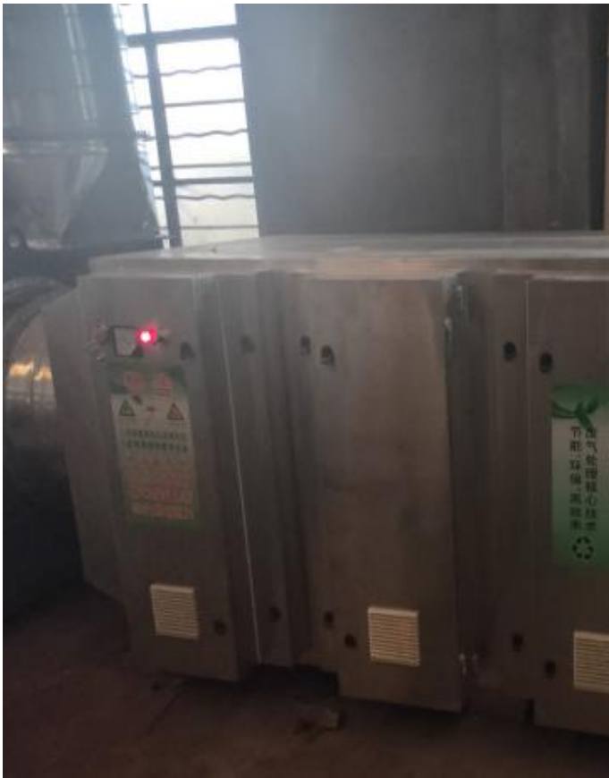
废气处理设施（油烟净化器）
