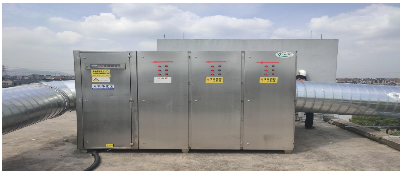
有机废气处理设施（等离子+光氧催化一体机）
