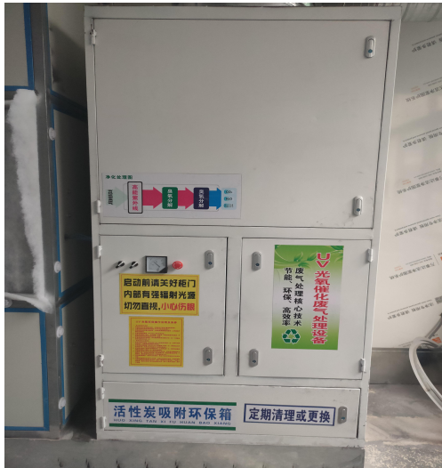
烤漆房配套的废气处理设施
