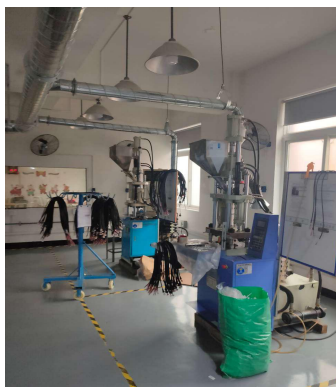
注塑废气收集管路
