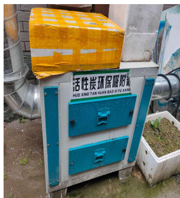
注塑废气处理设施（活性炭）
