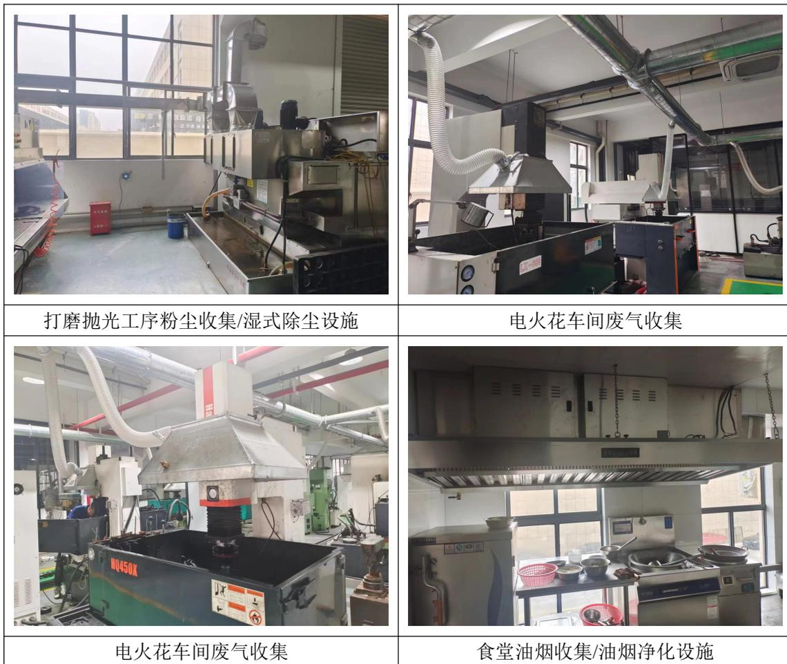
图 4-3 项目废气收集及处理设施图片
