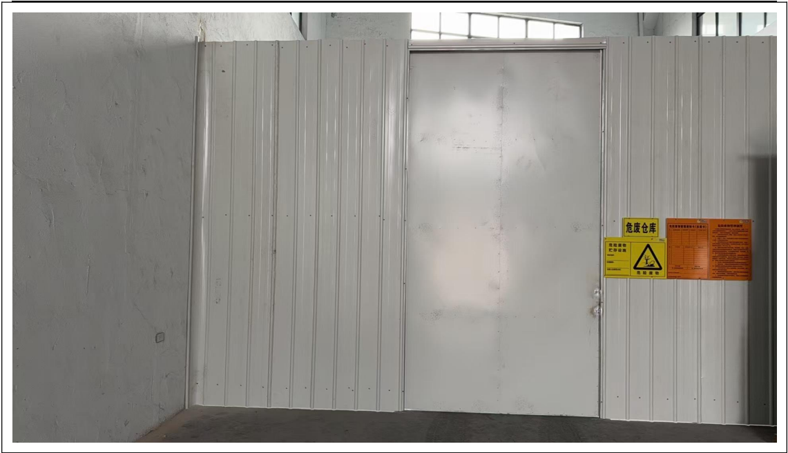
图 9-1 本项目危废暂存库
