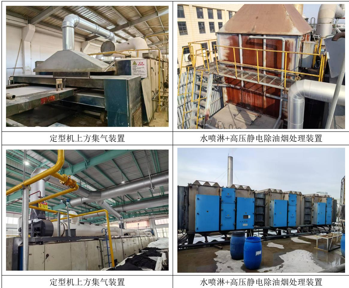
图 4-3 本项目废气处理设施照片
